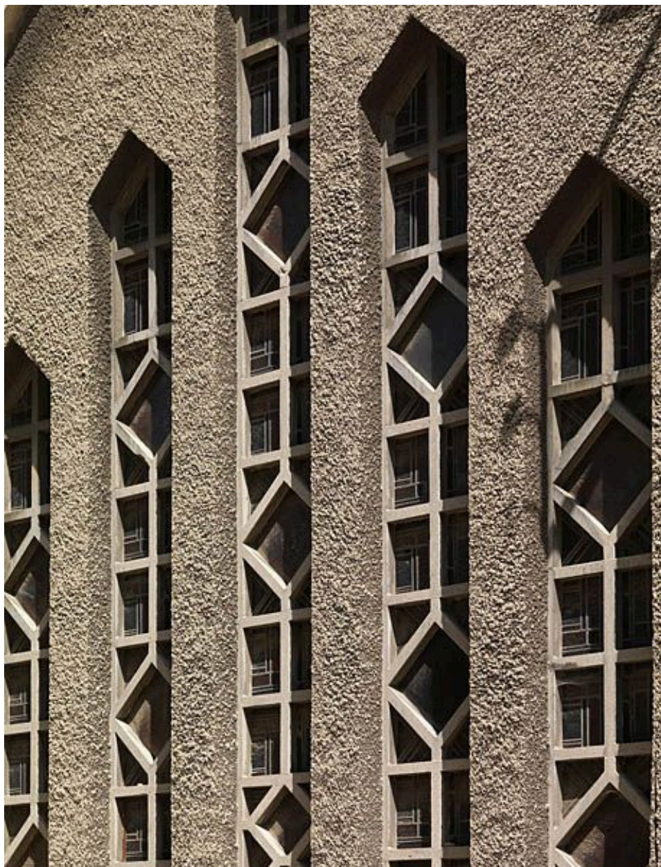
Détail d'une baie côté sud de la nouvelle chapelle.
