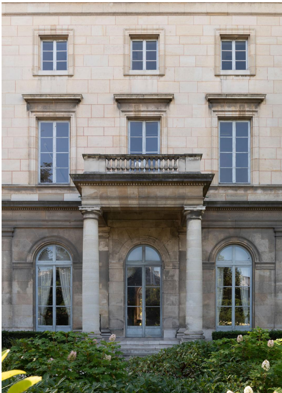
Façade principale, portique d'entrée
