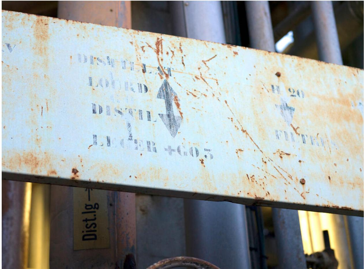
Unités Ouest - Zone de distillation (Unité 612). Rack limite des Unités Ouest. Signalétique du jeu de vannes du rack (appelé la "cuisine") permettant l'orientation des produits vers différents circuits.
