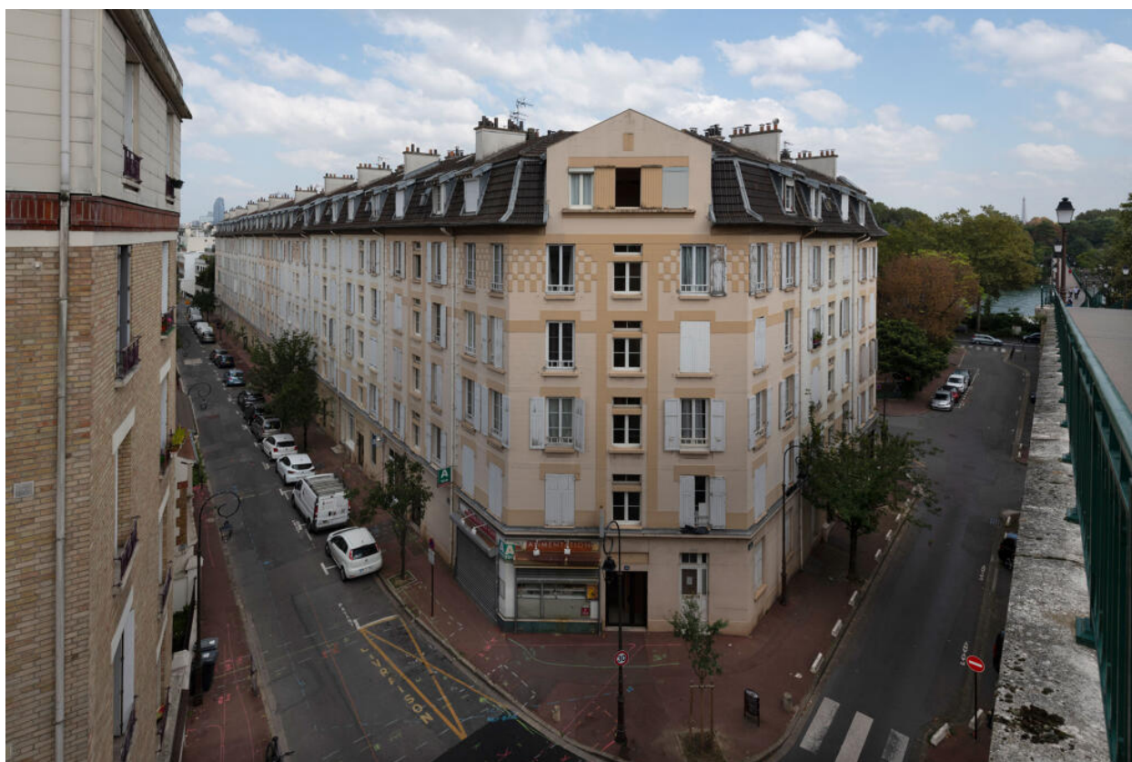
Immeubles, ensemble nord, pan-coupé et pignon sud-ouest, vue depuis la passerelle de l'Avre
