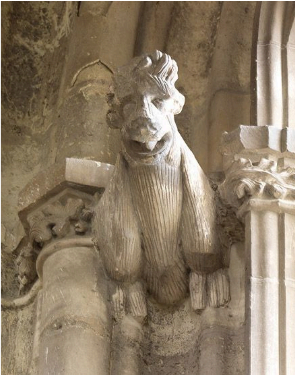
Tour nord, 2eme étage, mur ouest : détail du décor de la fenêtre.
