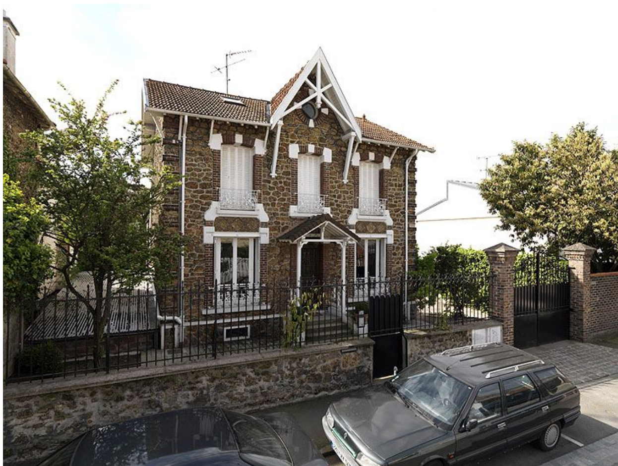
Vitry-sur-Seine, maison, 15 rue Sainte-Geneviève. Façade sur rue avec portail en ferronnerie.
