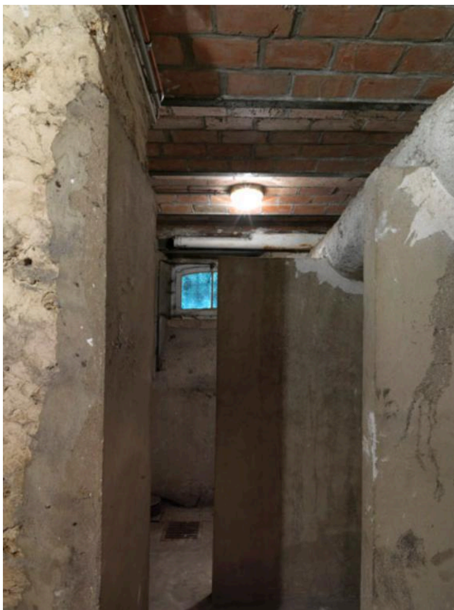
Anciennes cellules dans le sous-sol.
