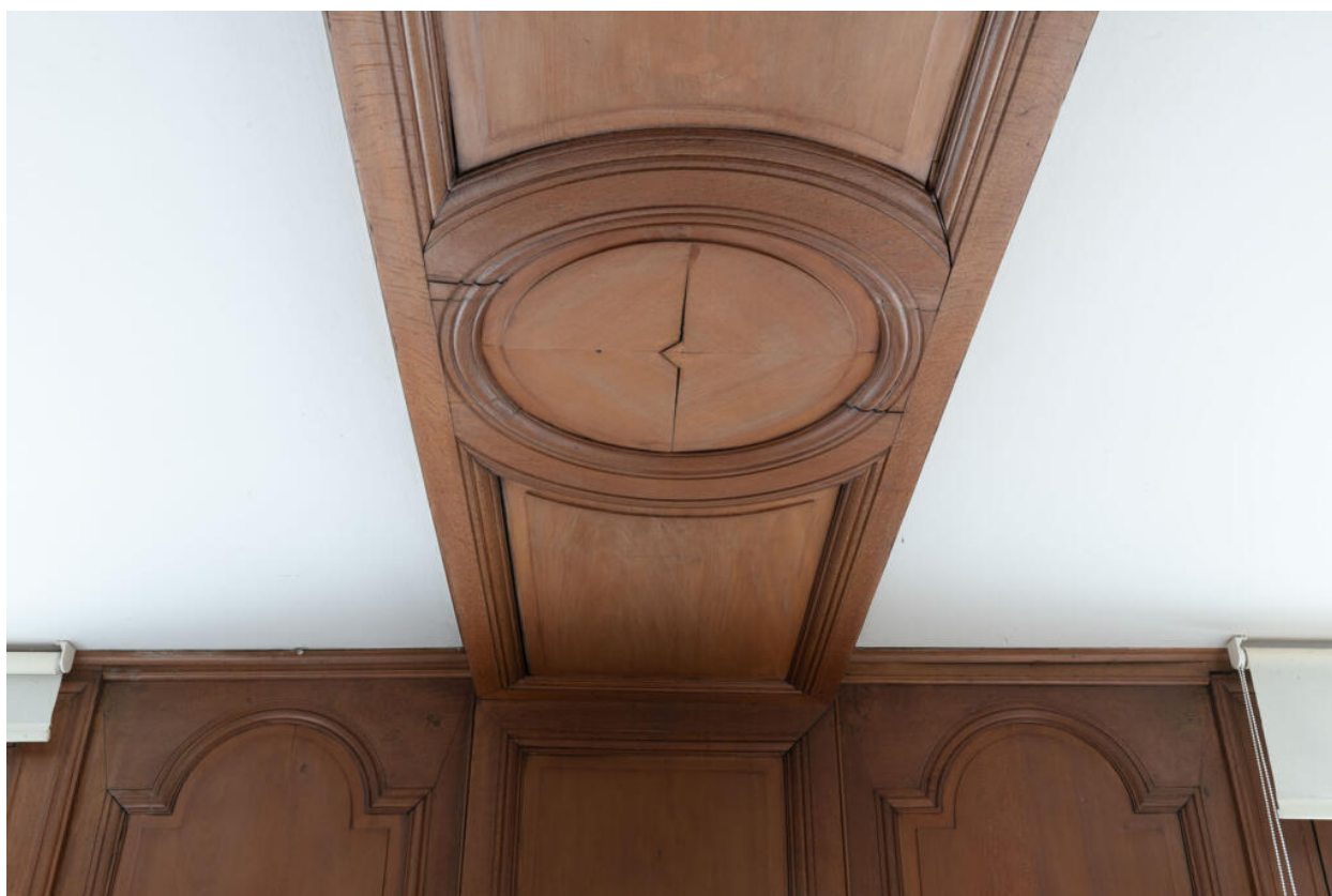
La salle à manger. Détail d'une boiserie du plafond.
