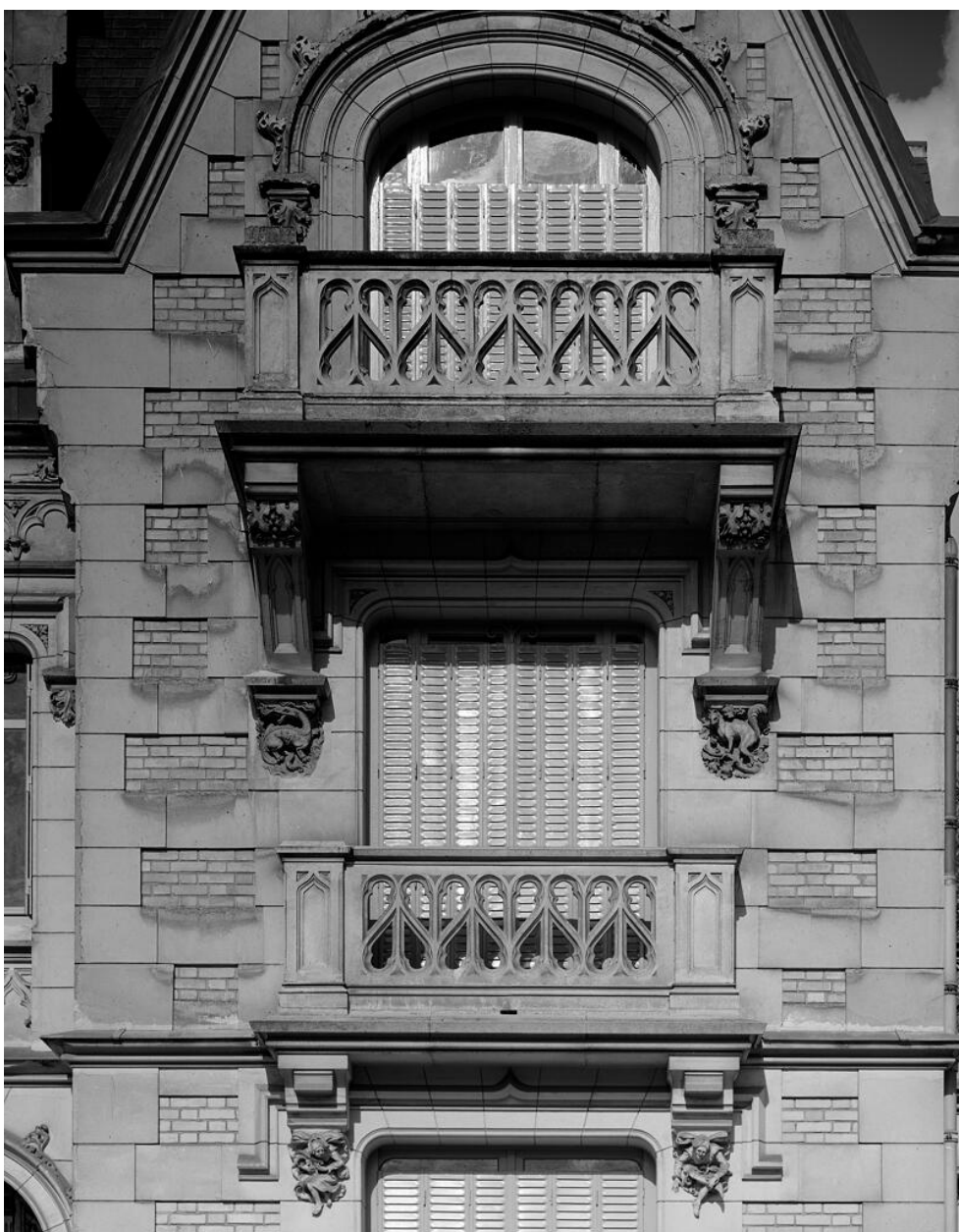
Détail des balcons de la façade antérieure.
