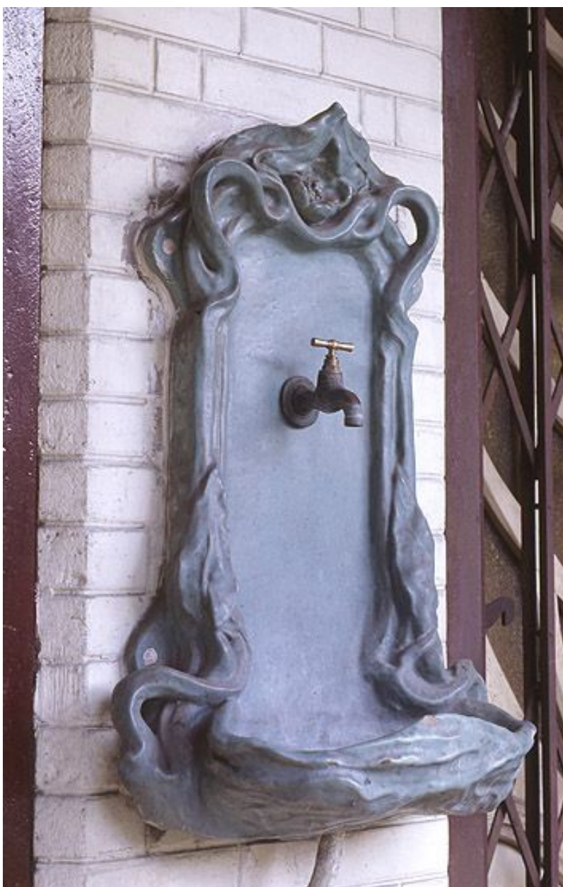
Détail de la fontaine en fonte ornant la façade.
