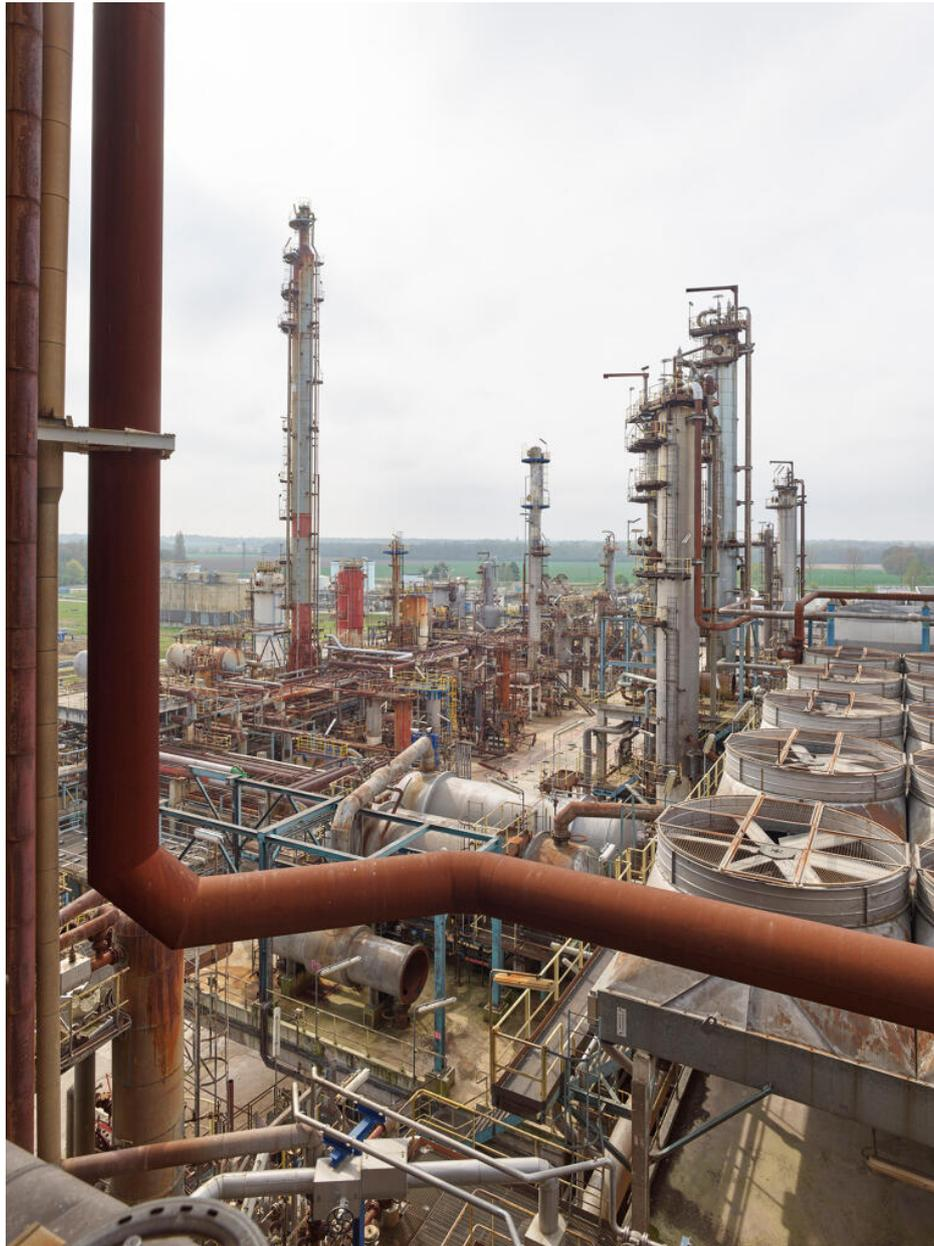
Unités Est - Zone FCC (Unité 651). Vue sur l'alkylation (à gauche) depuis la zone réactionnelle du FCC. À droite, la batterie aéroréfrigérants E 1001 .
