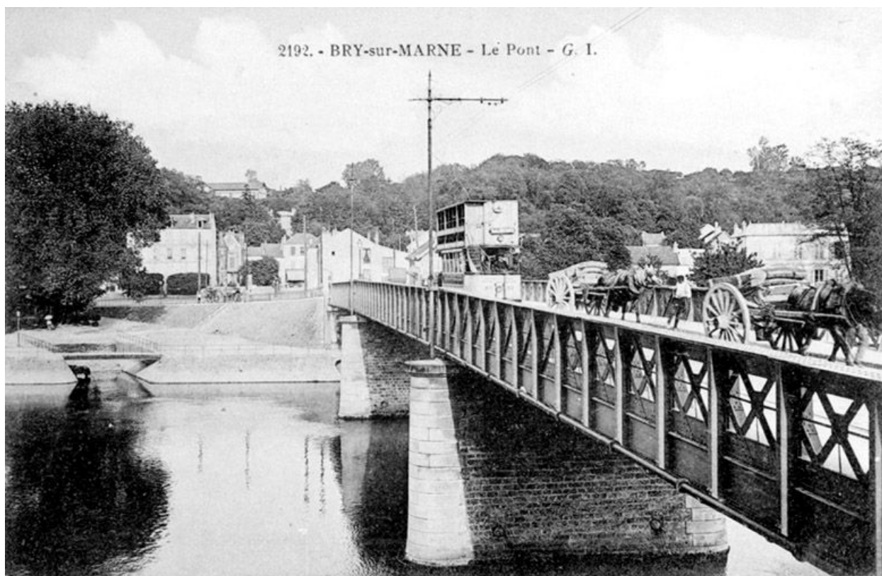
Vue du pont métallique. Carte postale. (Collection particulière)
