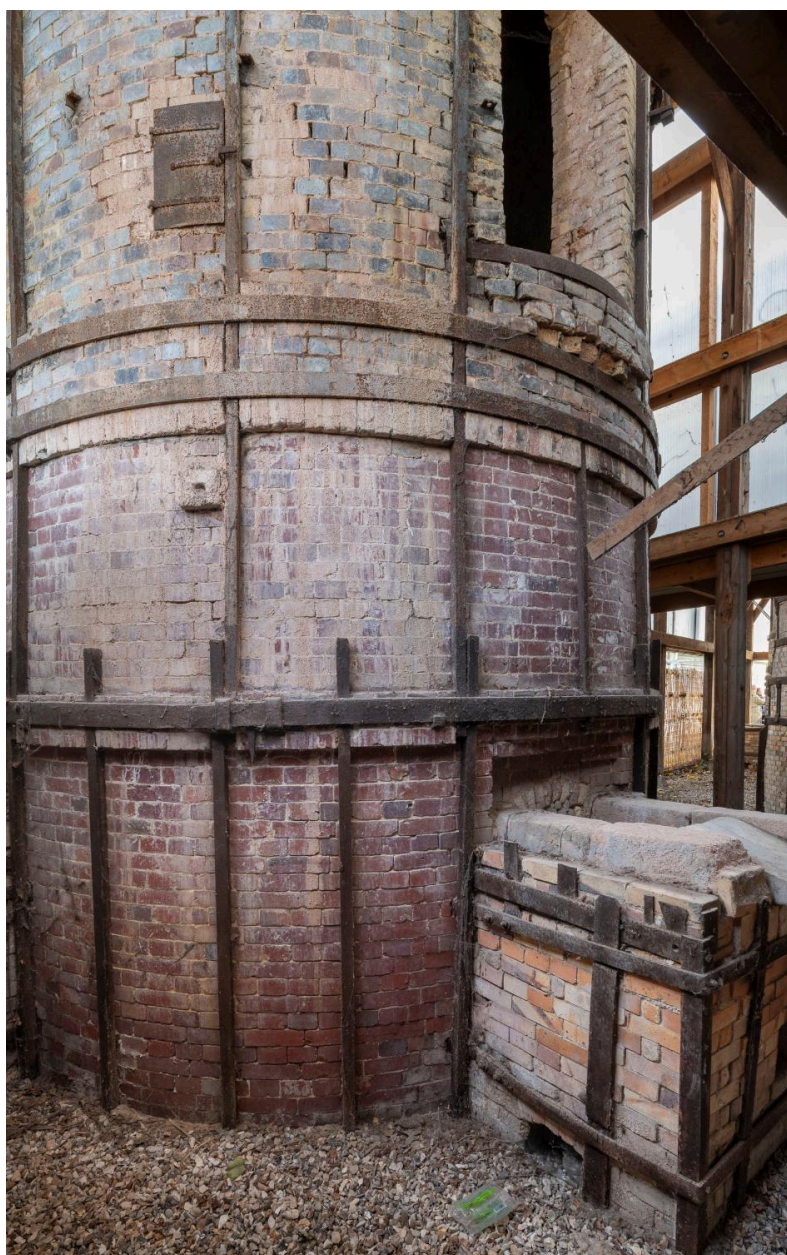
Base du four rond à globe et à flamme renversée, brevet 1878, mis en place avant 1912.
