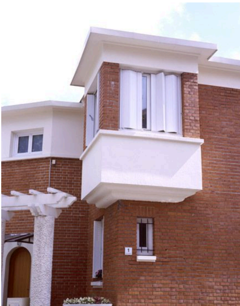
Détail de l'oriel d'une maison-jumelle, rue Proudhon.
