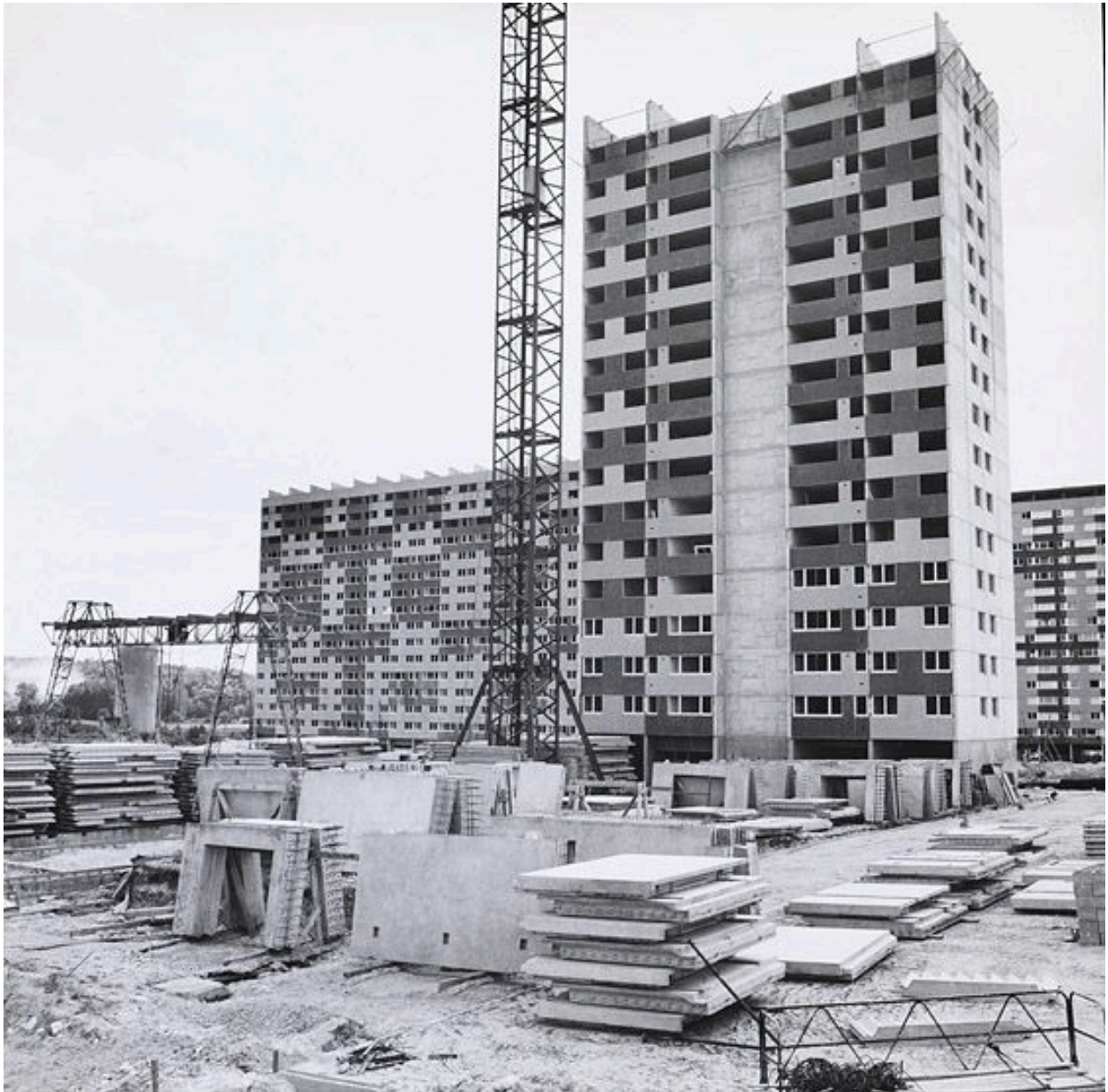
Construction des barres et des tours. (Cité de l'architecture et du patrimoine. fonds Ginsberg 100 boîte 3006)
