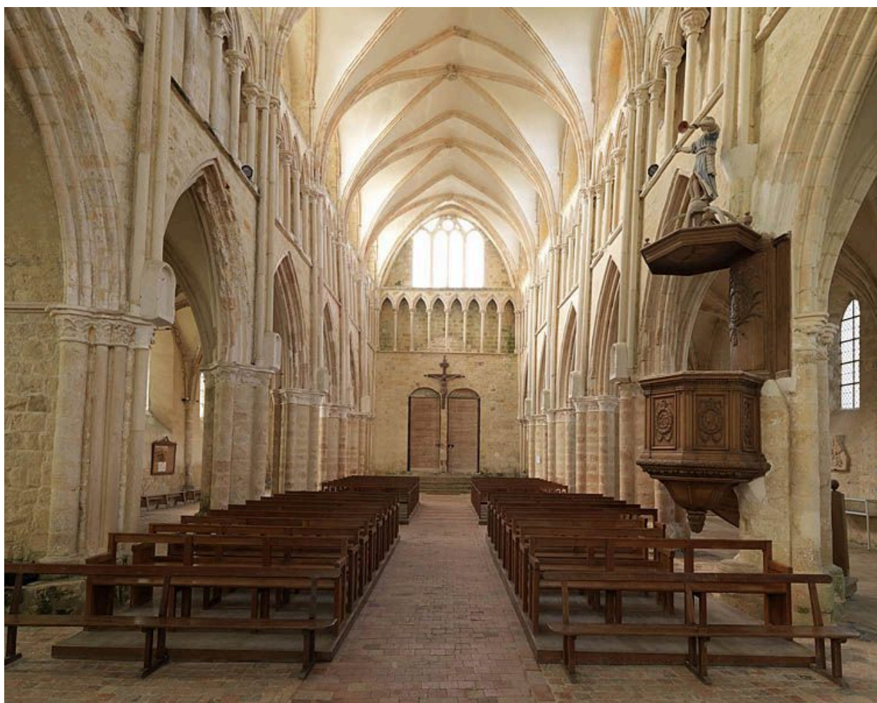
Vue intérieure, depuis l'abside.
