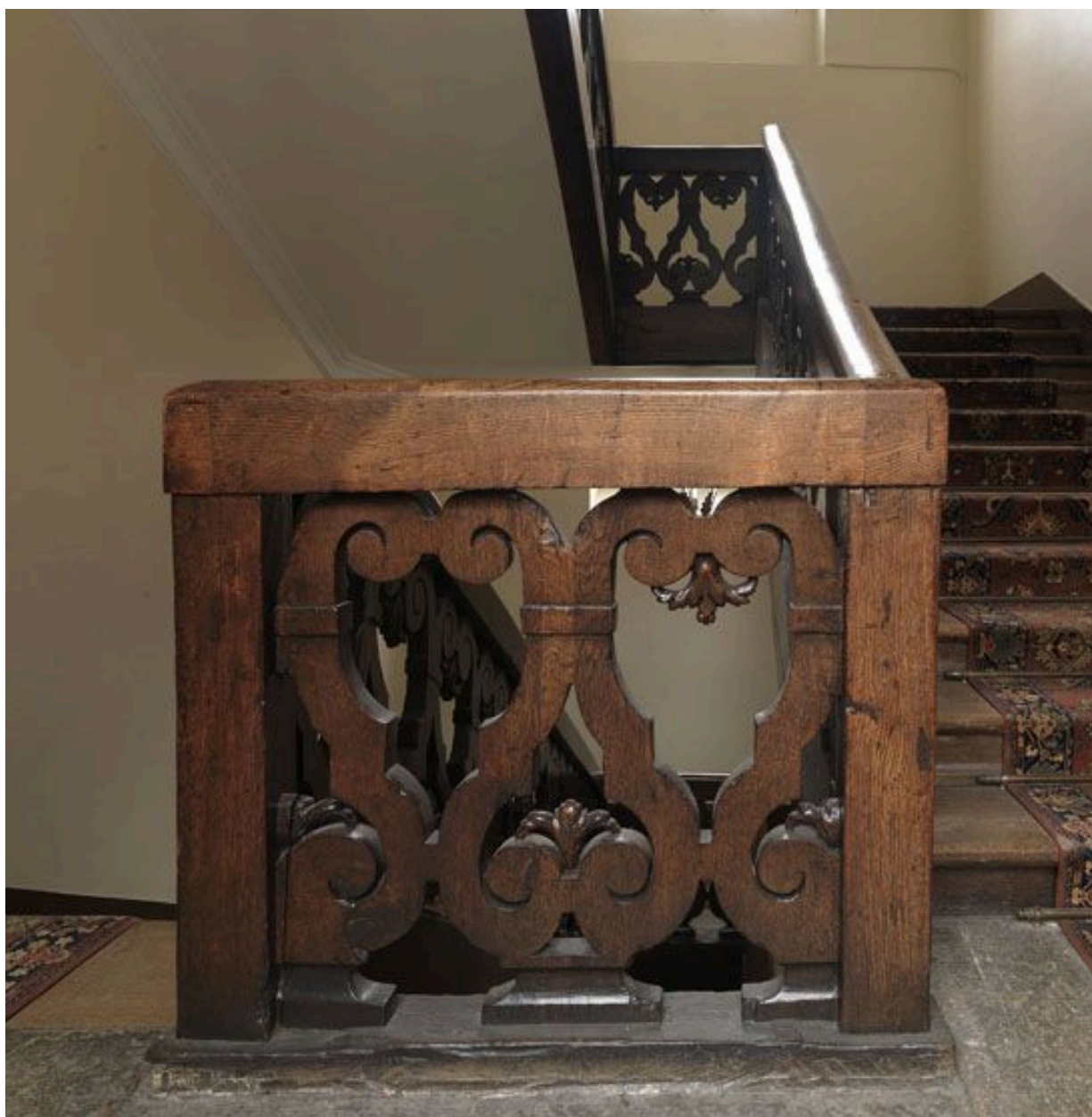
Balustre et demi-balustre du deuxième palier.
