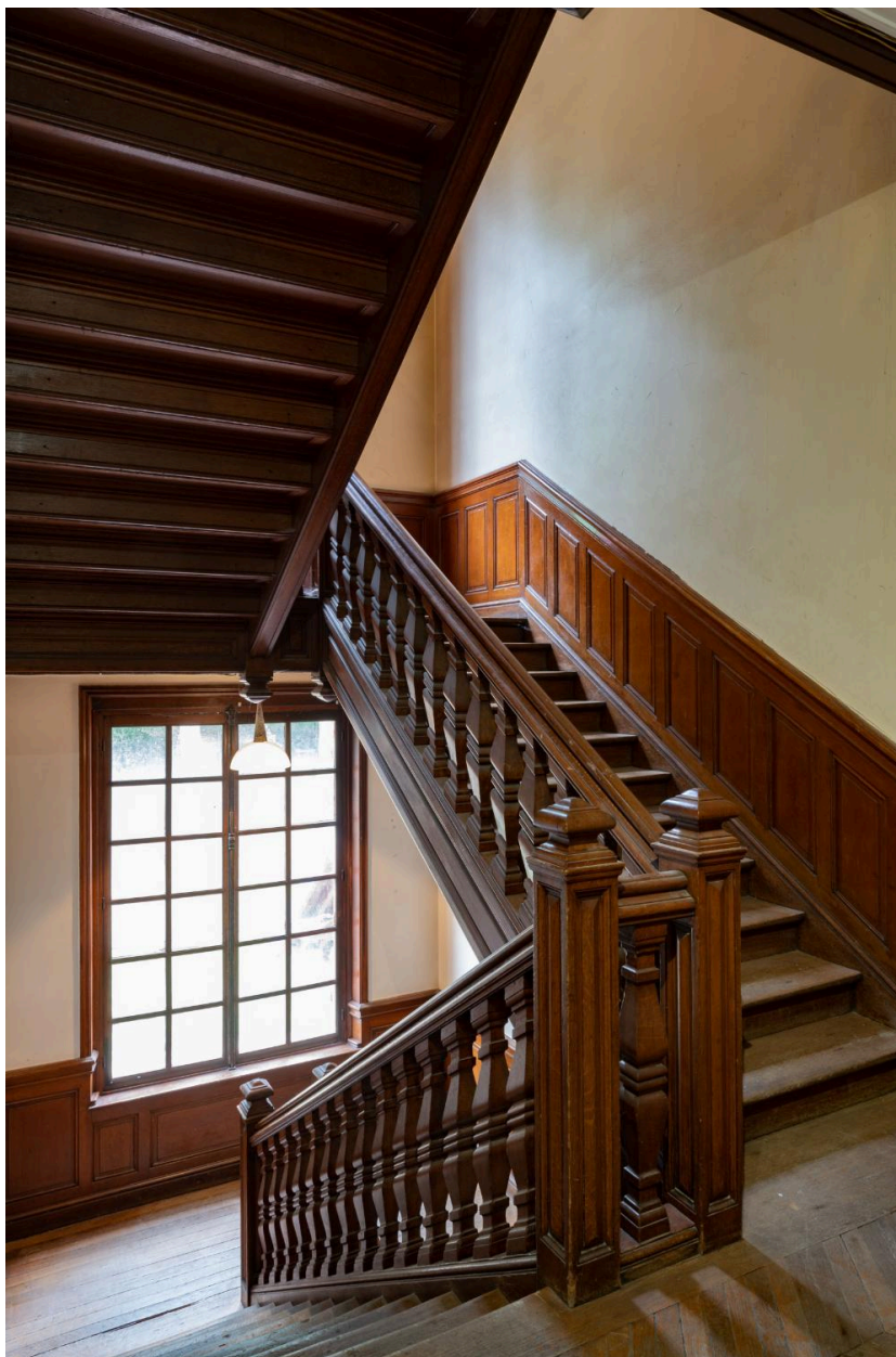
L'escalier en bois dont la rampe comporte des balustres
