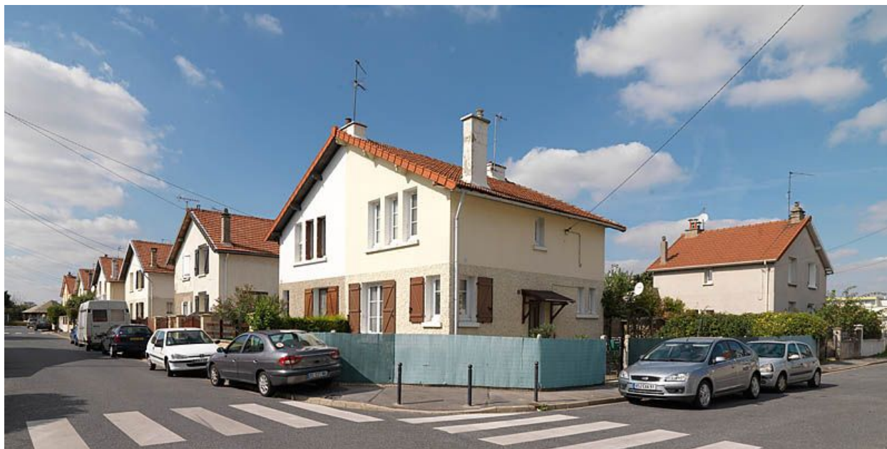
Orly, maison jumelée, 19 rue Louis-Asscher, 11 rue Anne-Georges-Leygues. Vue d'ensemble en 2011.
