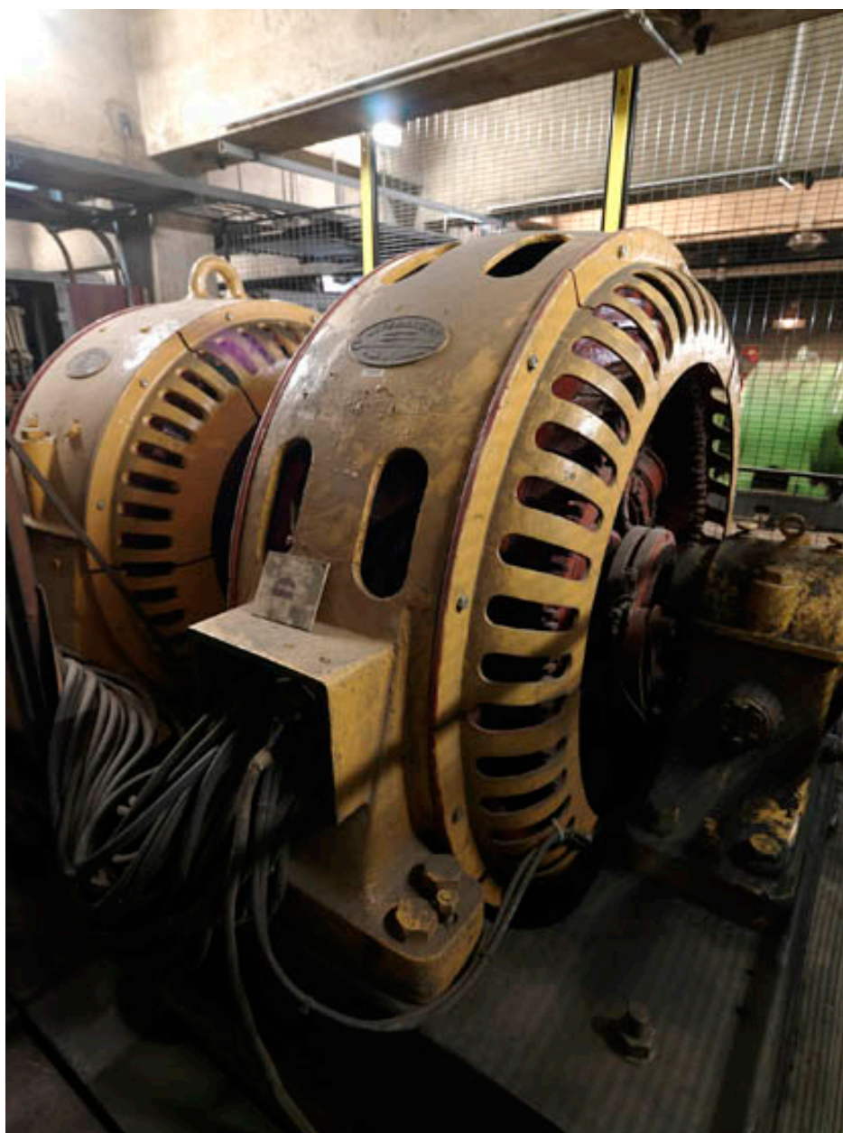
Plateforme d'essais. Entreprise Jeumont-Electric.
