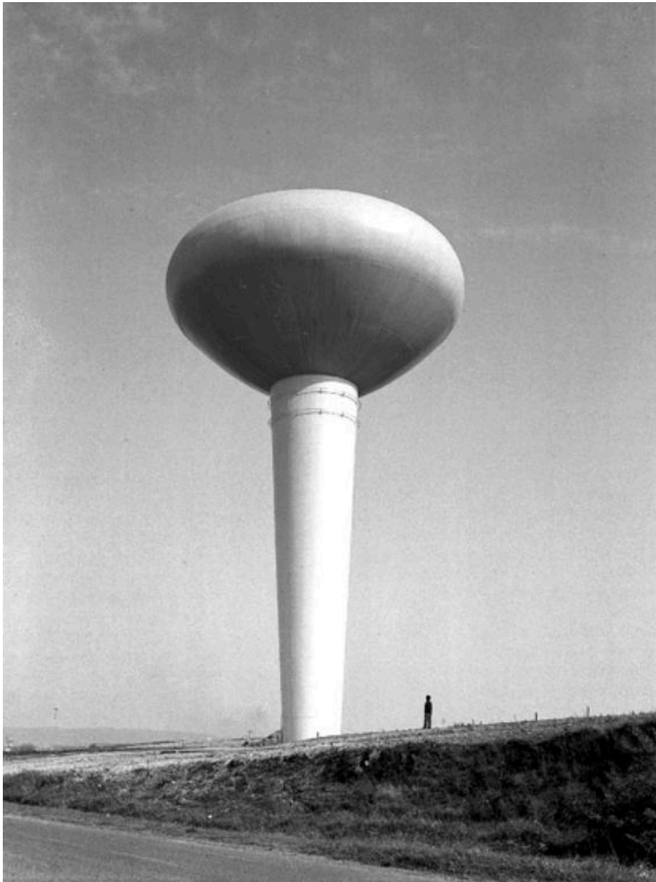
Vue du château d'eau juste après sa construction. (AM Mantes-la-Jolie, Fonds Bertin)
