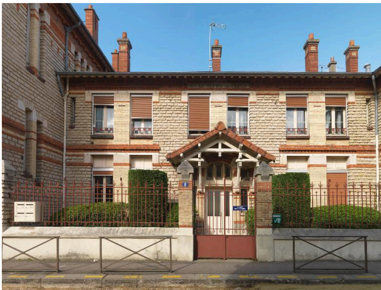
Bâtiment de l'entrée principale.
