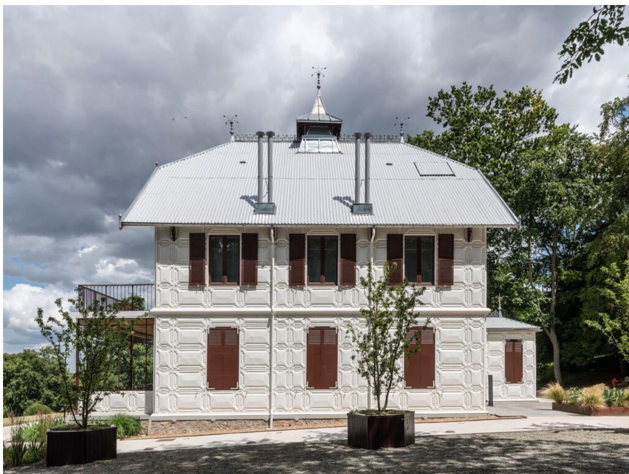
Façade latérale ouest.
