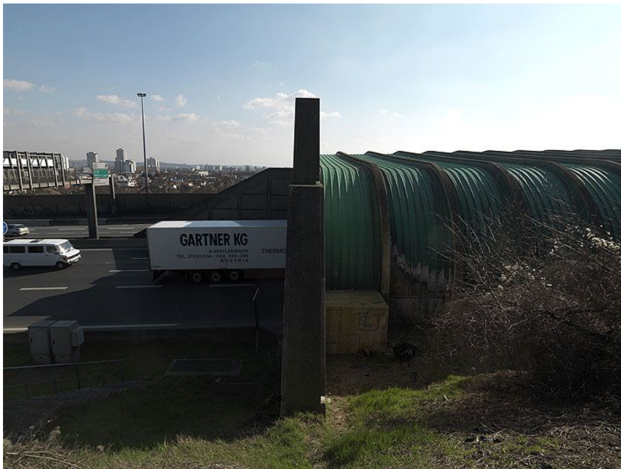
Vitry-sur-Seine. Entrée du tronçon couvert de l'autoroute A86.
