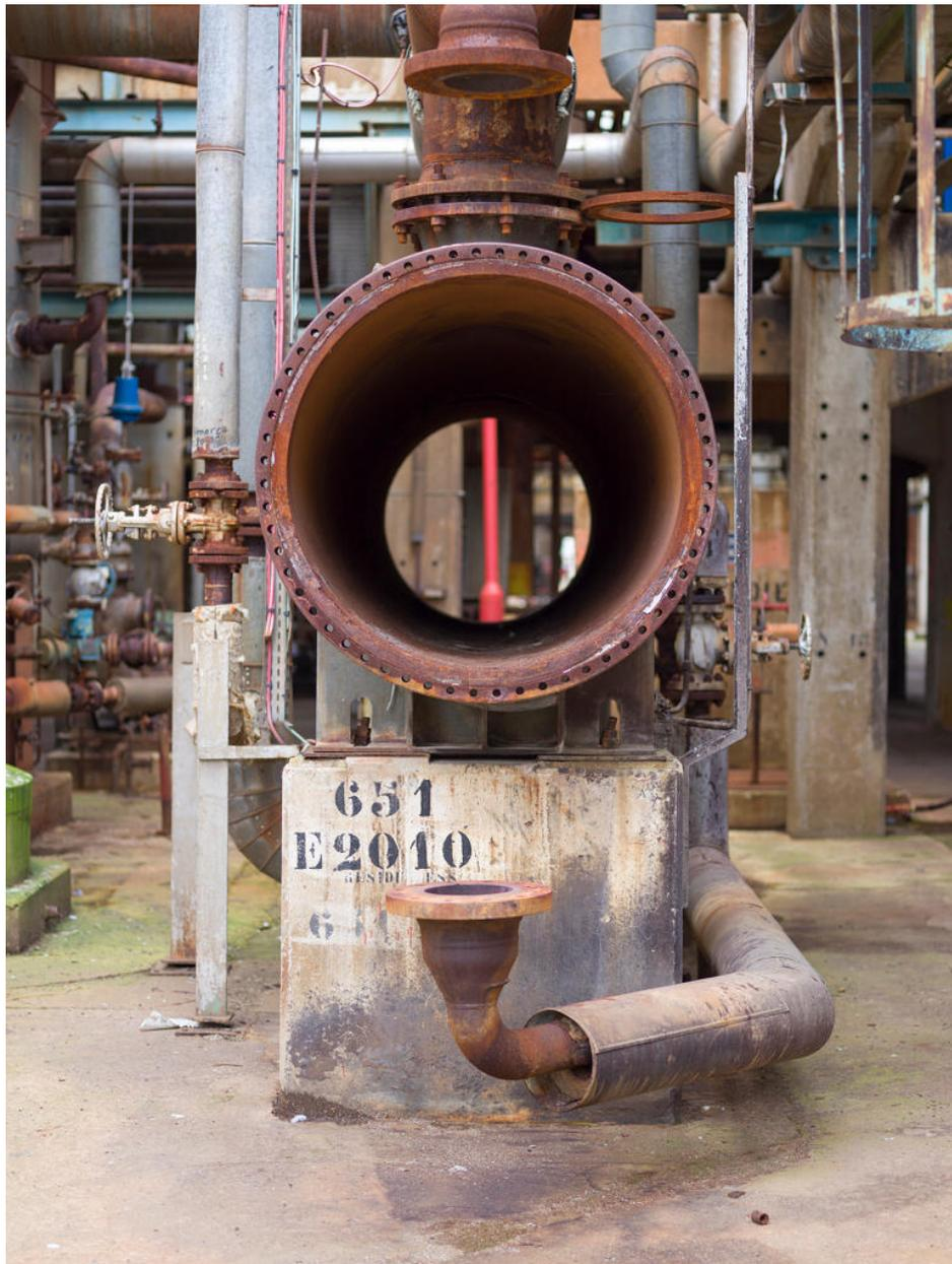
Unités Est - Zone FCC (Unité 651). Calandre de l'échangeur tubulaire E2010 sur l'unité FCC (651). Equipement servant à l'échange de calories entre deux fluides ayant des températures différentes.
