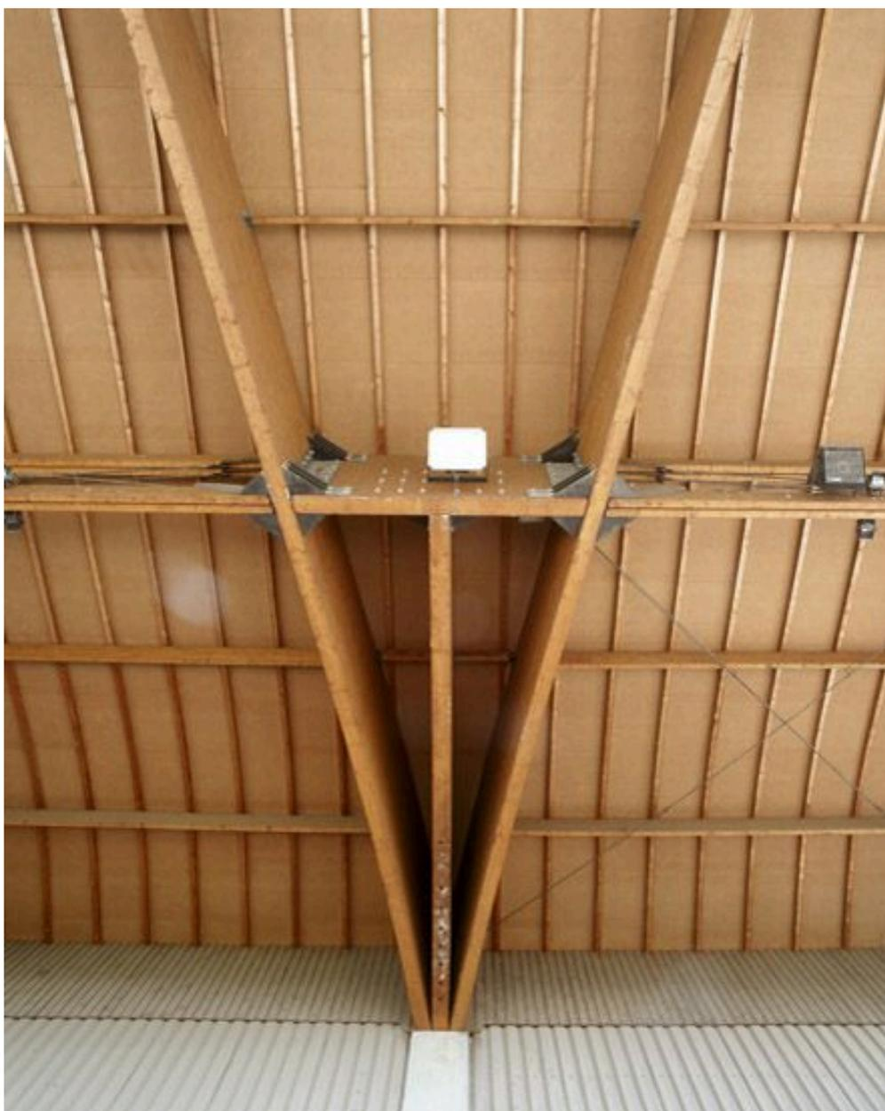
Les tribunes : détail de la charpente en lamellé-collé.
