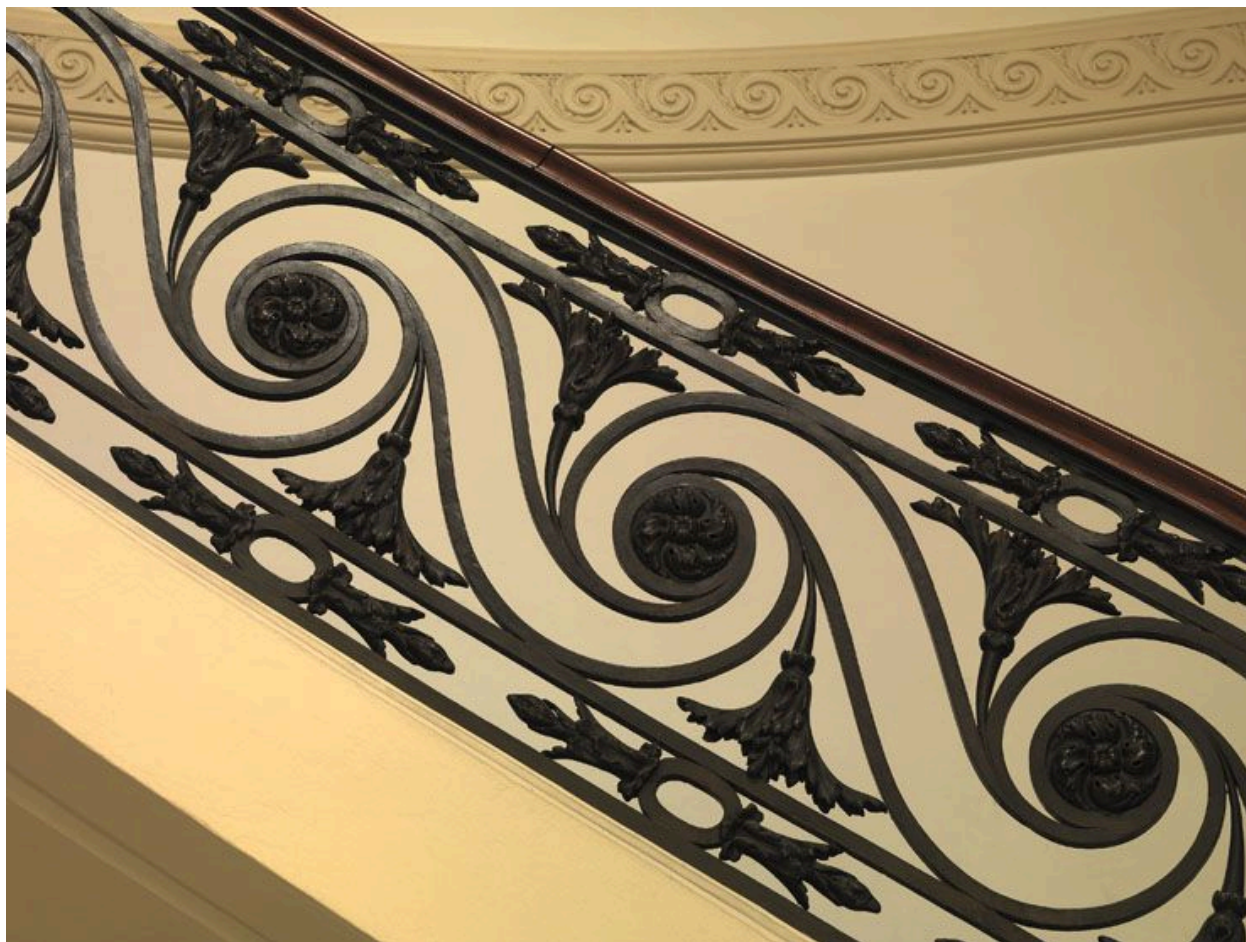
Détail de la rampe.
