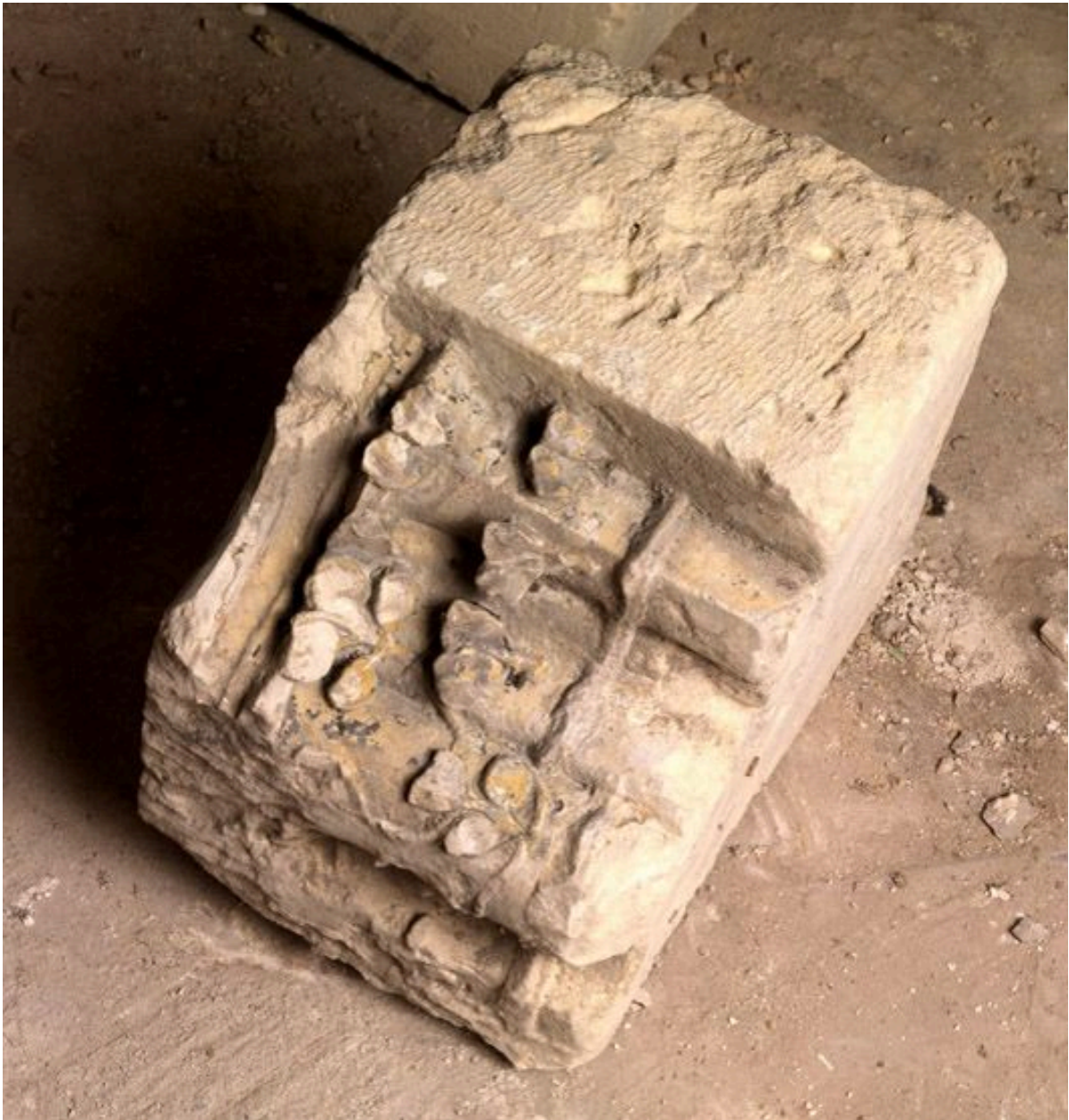
Pièce C 12 : groupe de chapiteaux engagés à deux rangs de feuilles. Cette pièce provient de la 2e chapelle rayonnante côté nord. 1er tiers 14e siècle.
