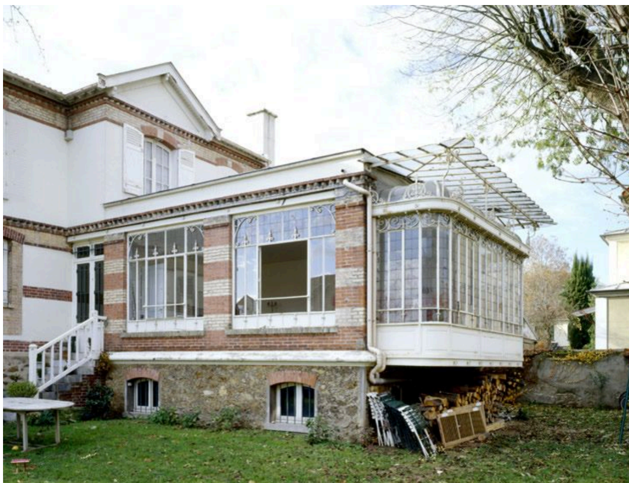
Maison, 24 bis quai Victor Hugo. Vue de l'extension à l'arrière de la maison, d'une vaste pièce faisant office de jardin d'hiver.
