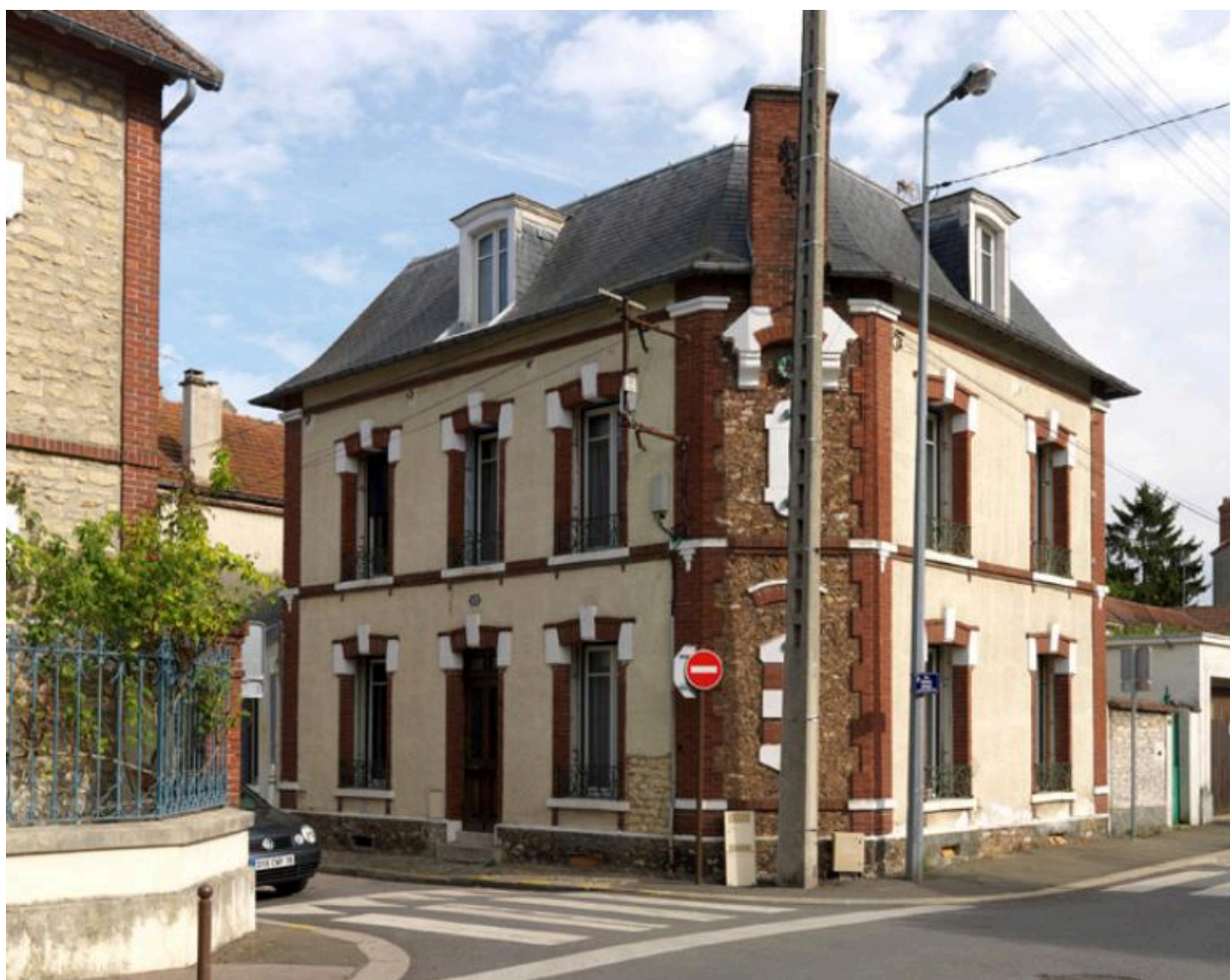
Vue d'ensemble de la maison.
