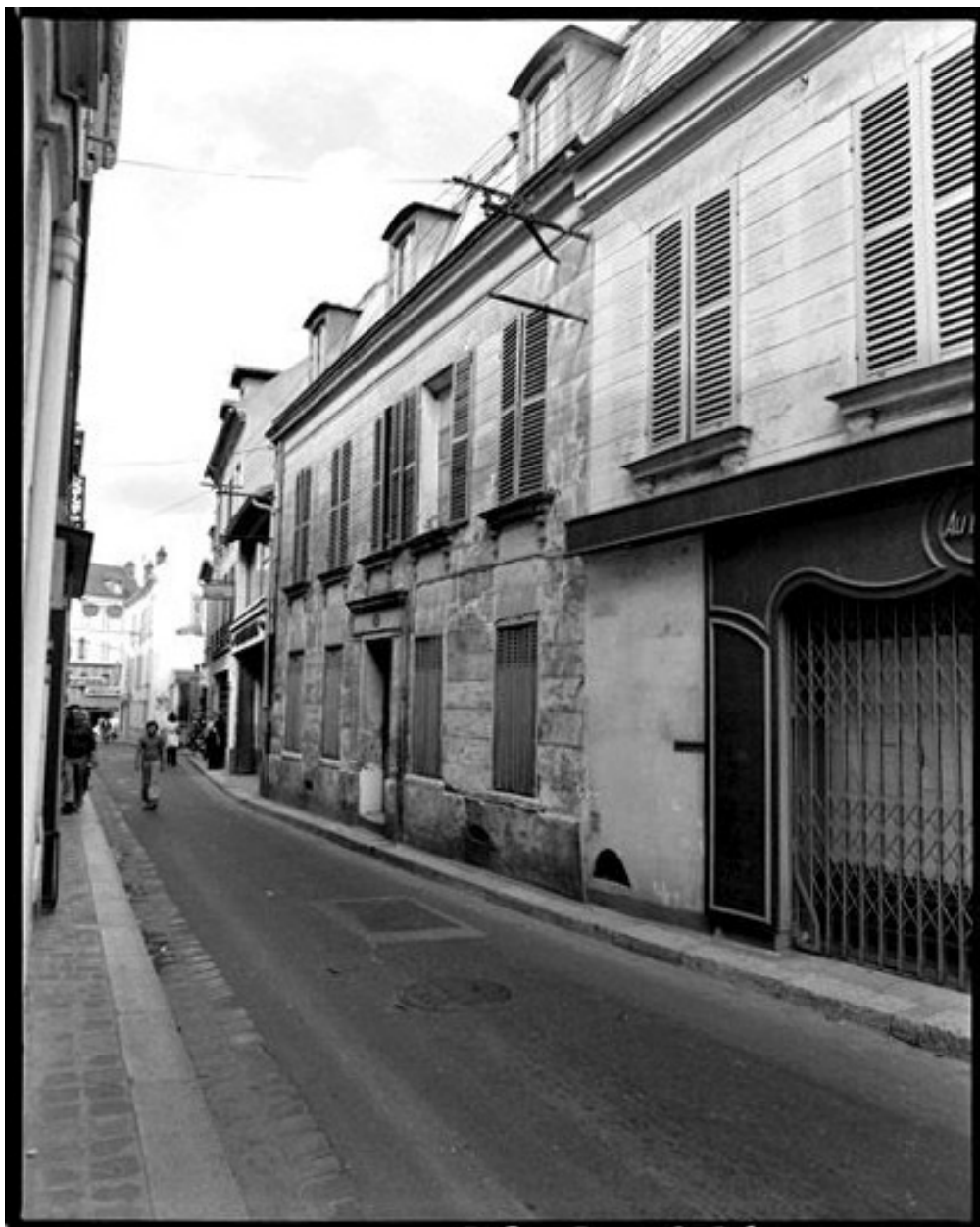
Maison, Colmar (rue de) 11. Vue d'ensemble.
