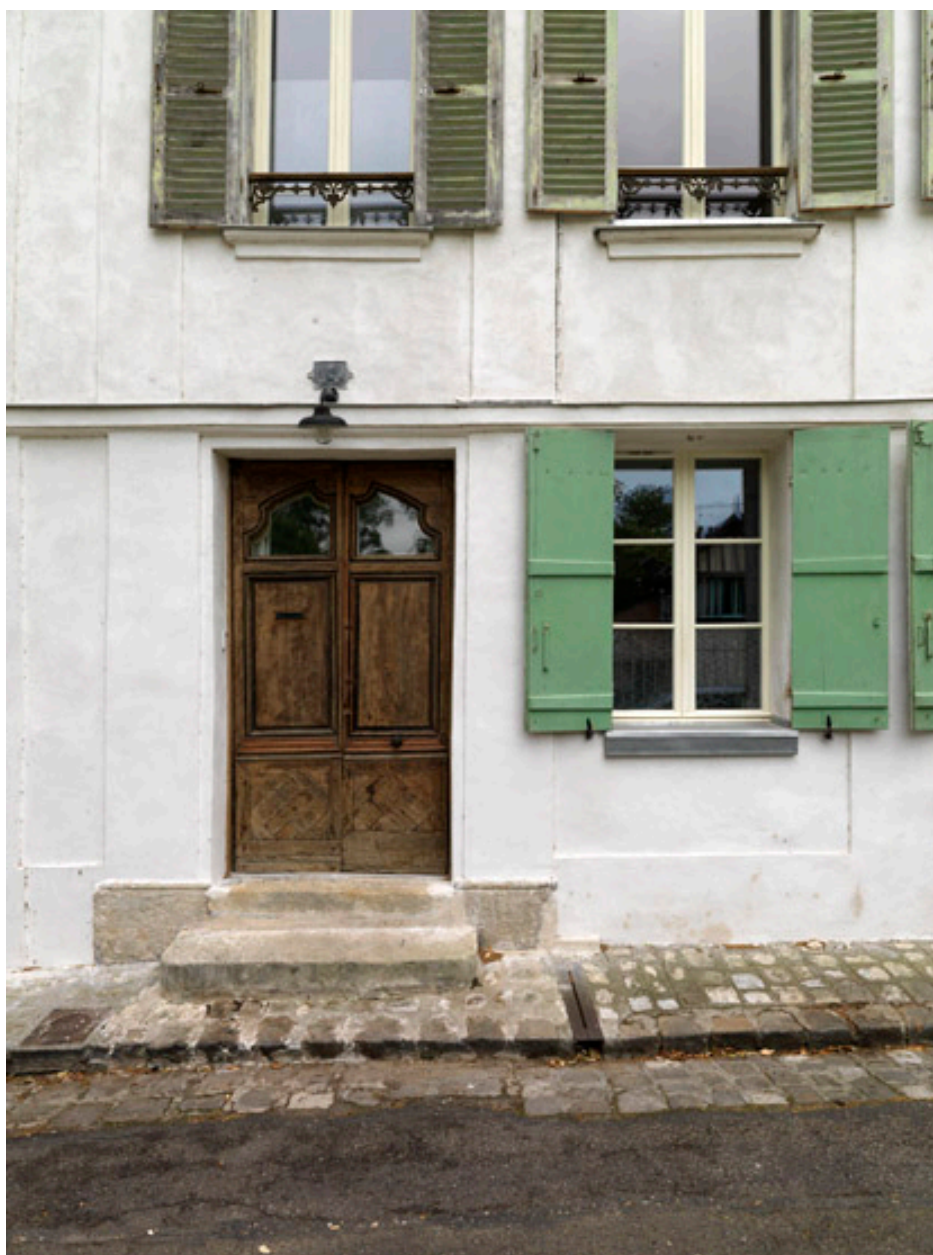
Maison de bourg, 14 rue de l'Abbé-Hua. Détail de la porte piétonne.
