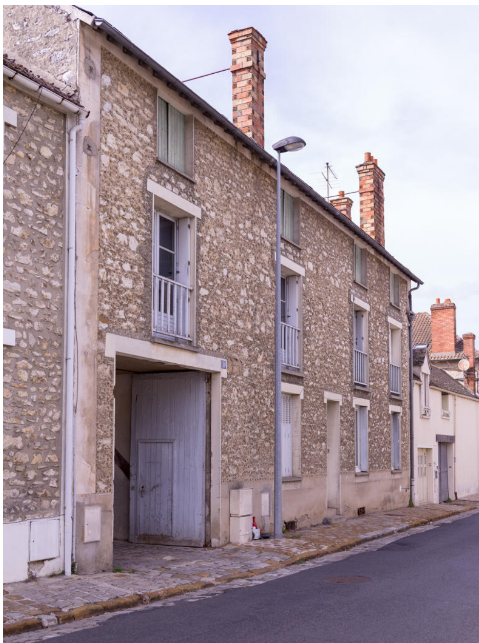
Vue générale du corps de bâtiment sur rue de l'ancien séchoir, depuis le sud-est.
