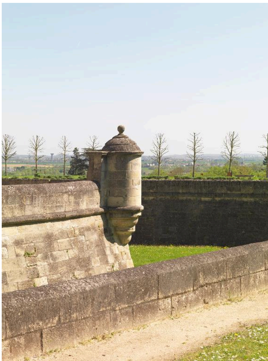
Les douves sèches et l'échauguette à l'angle sud-est du terre-plein supportant le château. Vue prise depuis l'ouest.
