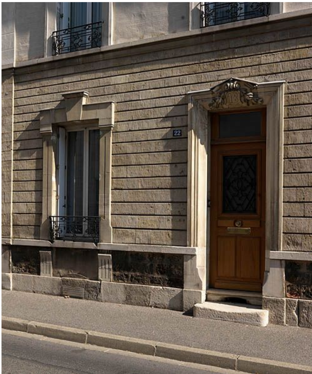
Maison au 22, rue Saint-Faron : détail du rez-de-chaussée.
