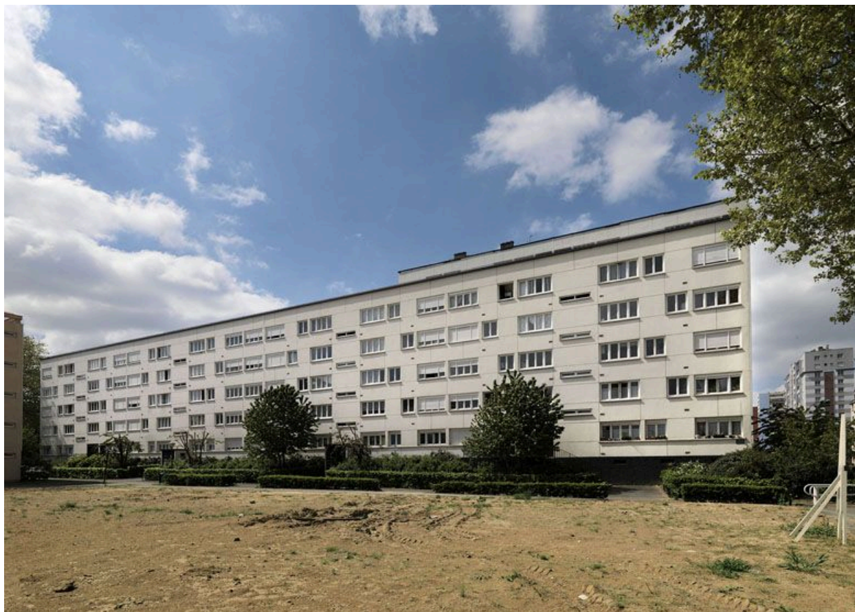
façade arrière de la barre H.
