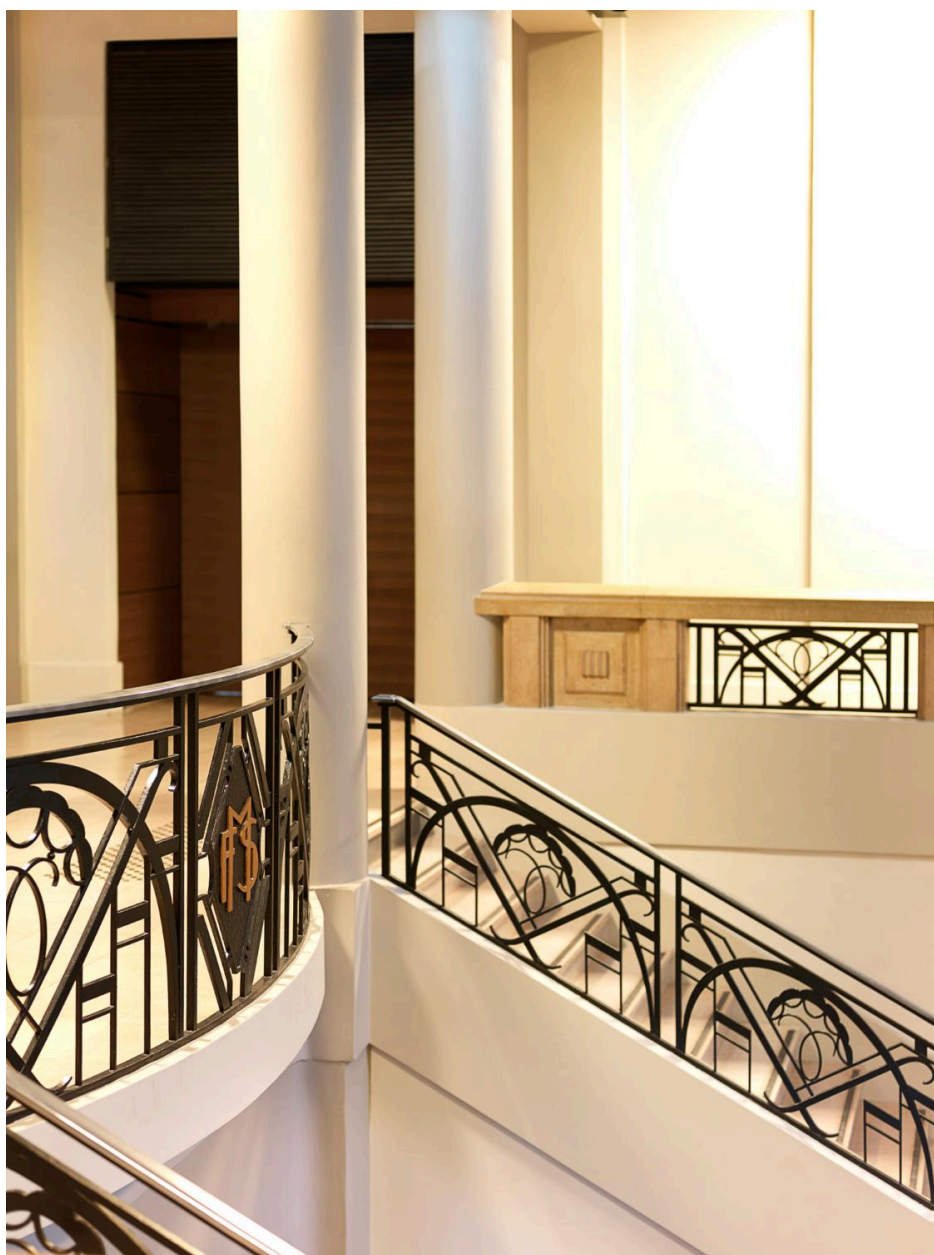
Escalier d'honneur, détail des galeries
