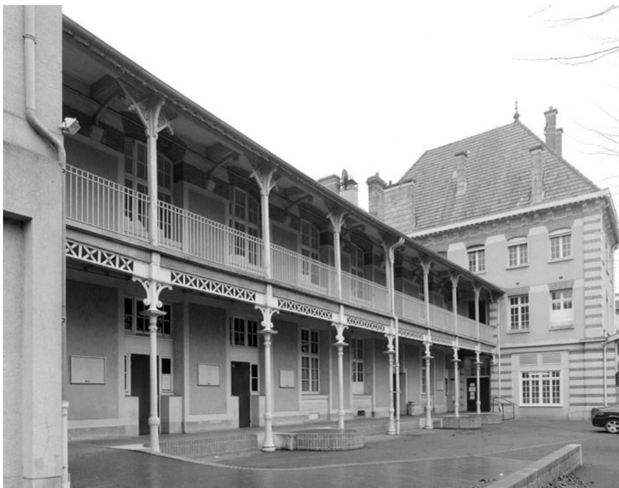
Elévation sud (sur la cour), avec les galeries de distribution.
