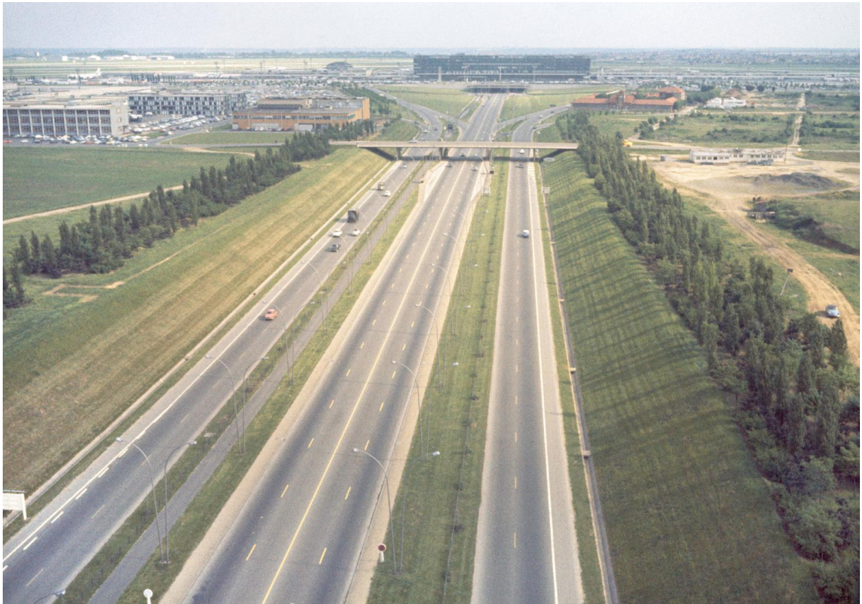
1962, les Installations Terminales vues depuis le nord.
