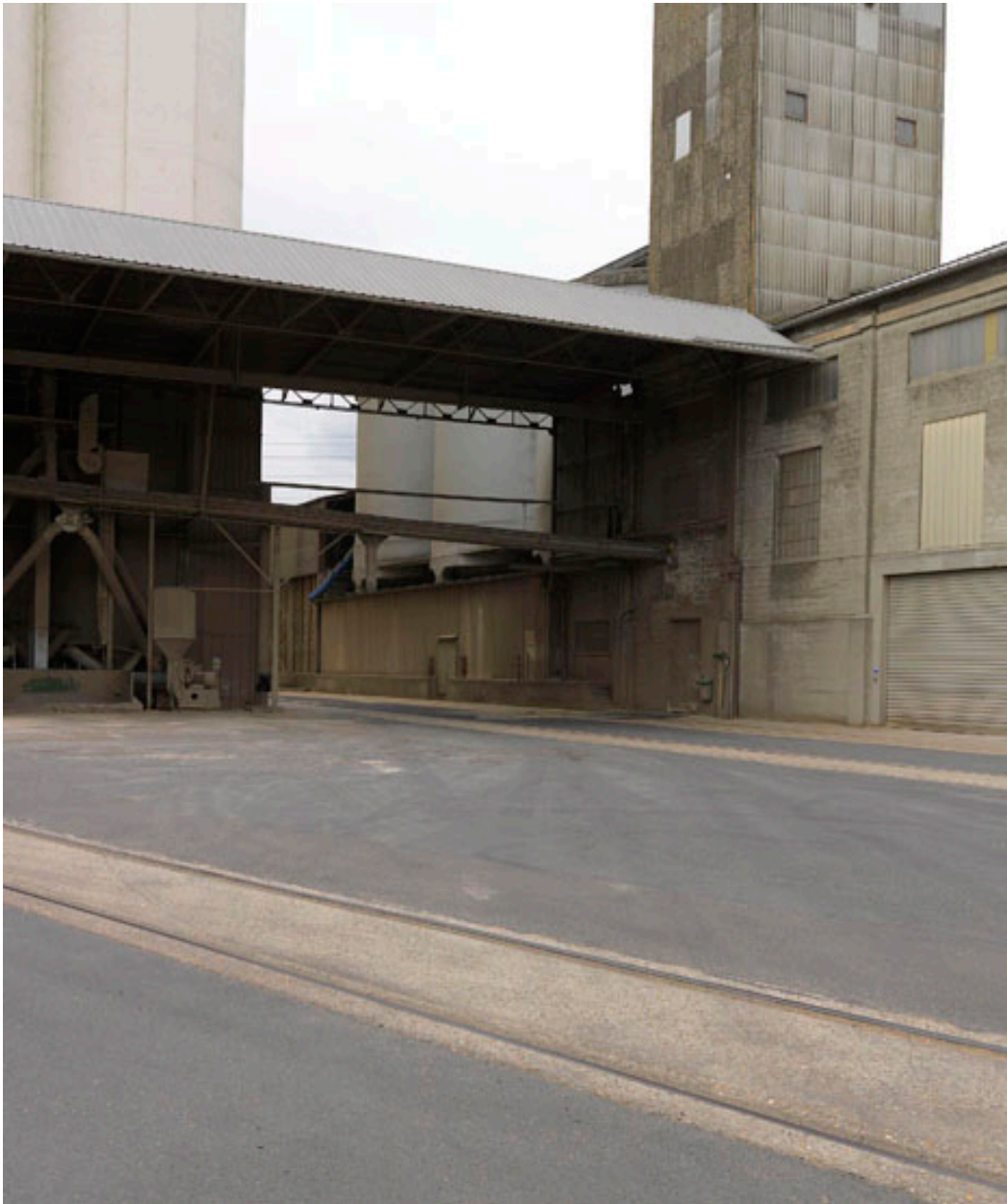
Silos de l'UNCAC de la Grande Paroisse, aujourd'hui Invivo. Vue extérieure du Silo 2.
