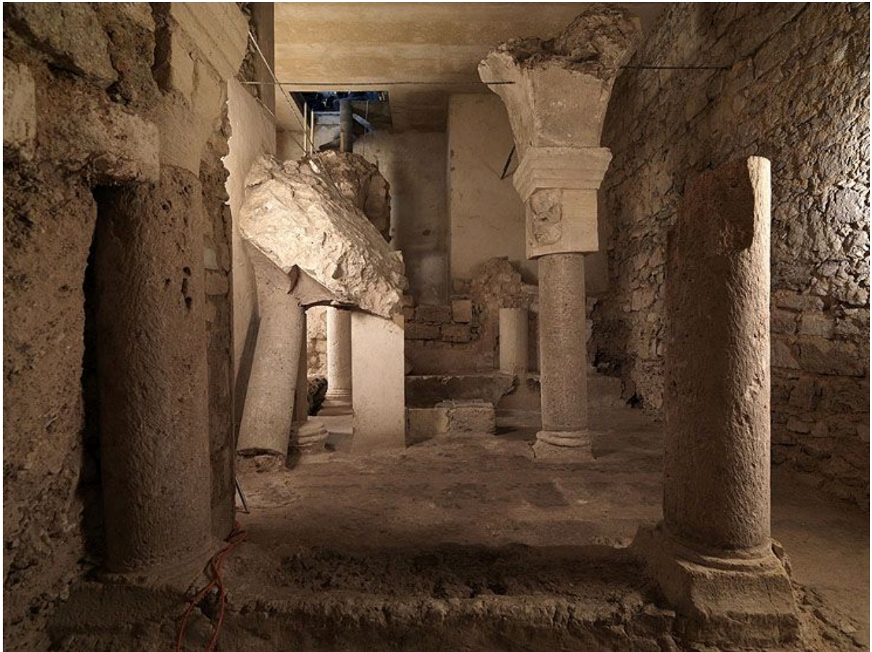
La crypte : vue d'ensemble, depuis l'est (vue horizontale).
