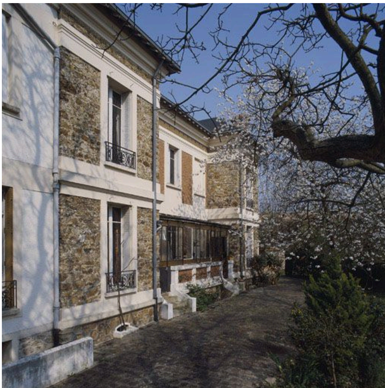
Vue de la façade arrière de la maison, 2 rue de Châtillon.
