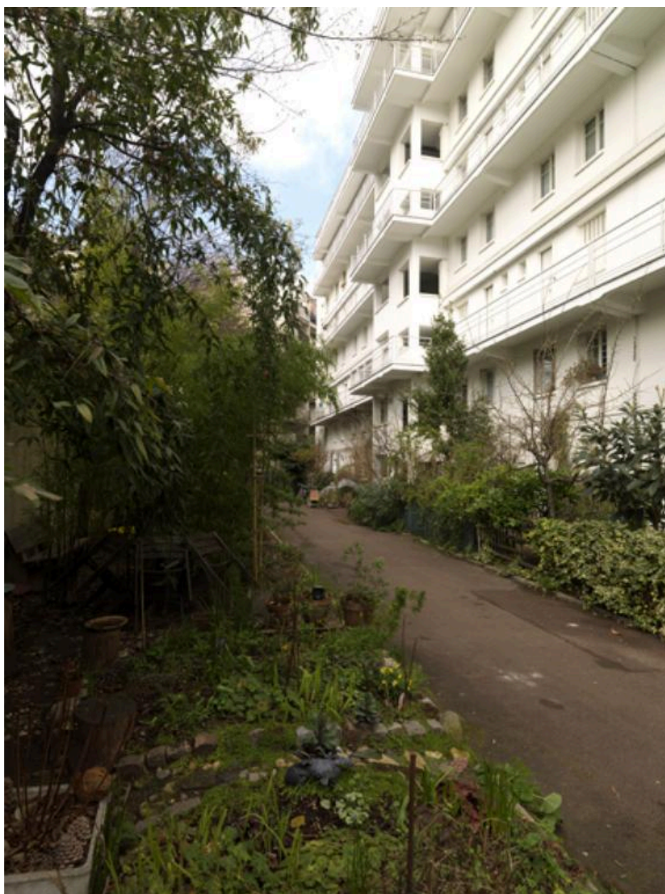
Vue des coursives du bâtiment C et de la cour boisée
