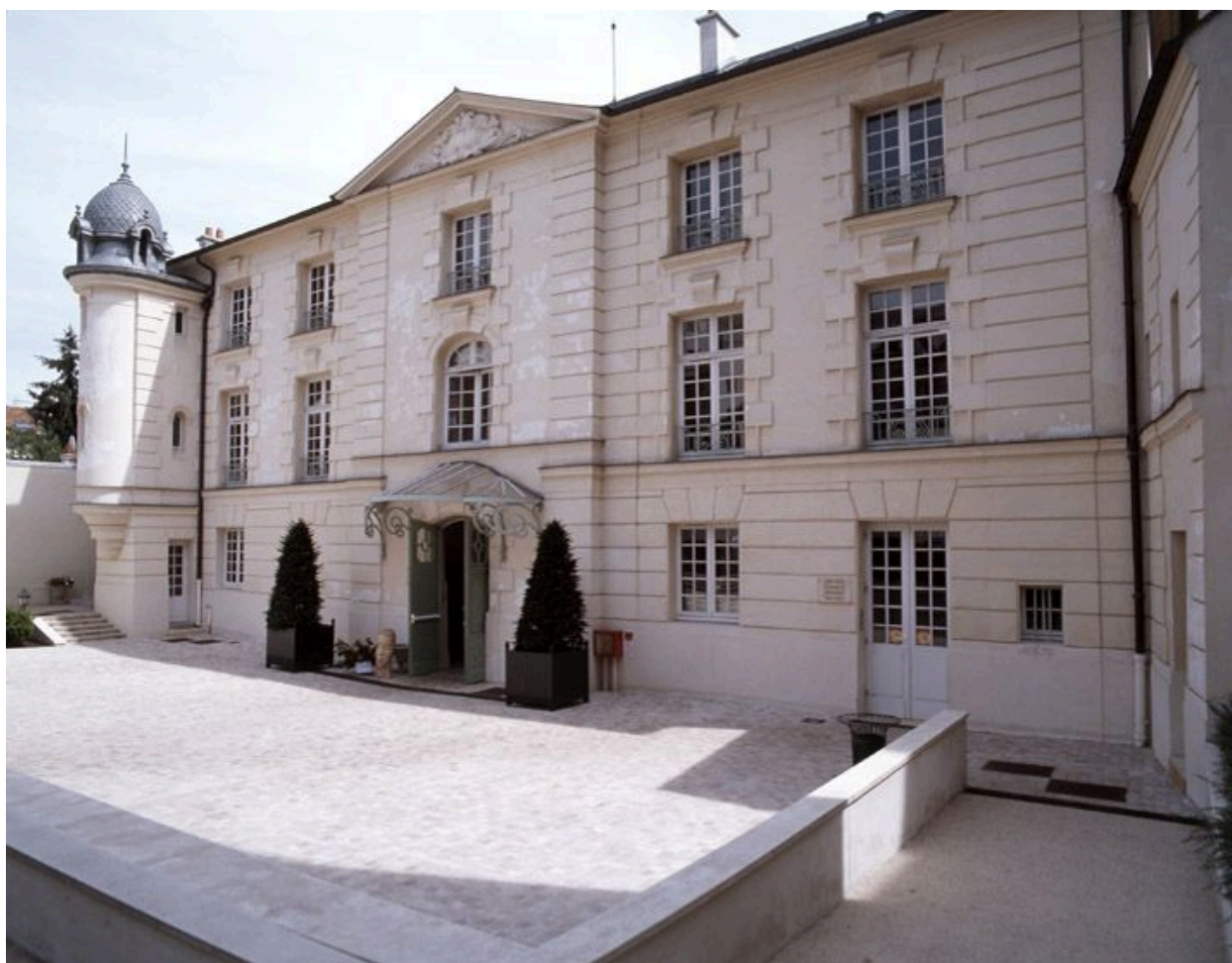
Façade antérieure après rénovation.
