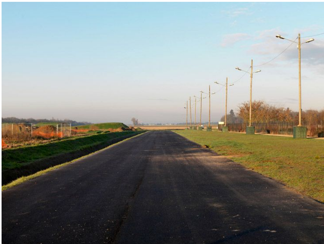
Palaiseau, avenue de la Vauve. Allée principale du chantier du campus EDF.
