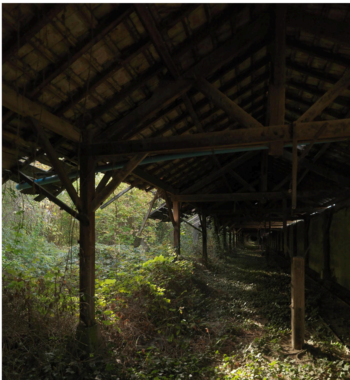
Vue générale du hangar de production des cordes et torons.
