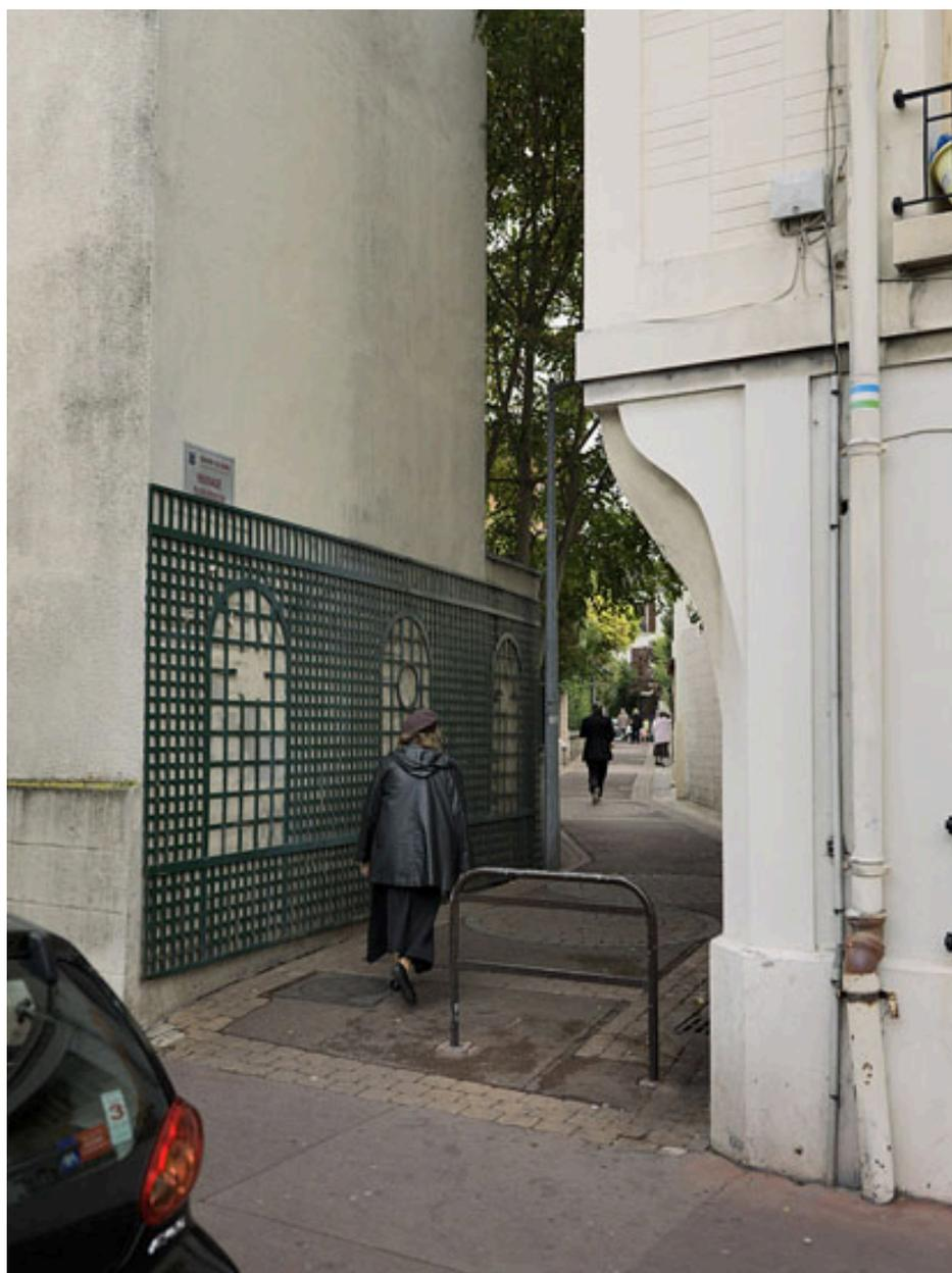
Détail de l'encorbellement faisant transition entre le premier niveau en surplomb et le rez-de-chaussée, sur le passage Dubuisson.
