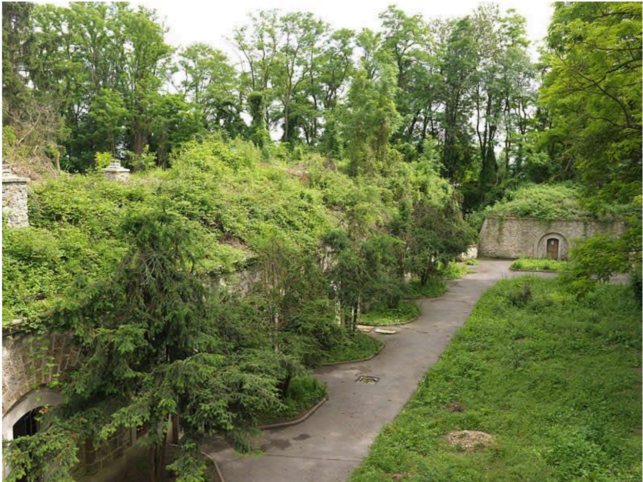
Vue générale de la partie intérieure de la batterie sud depuis sa partie supérieure.
