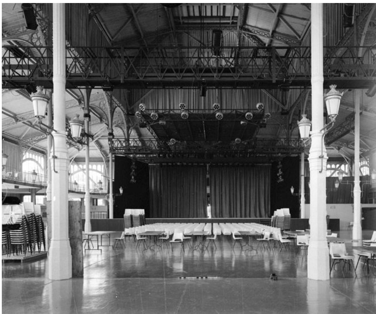
Base des colonnes en fonte. Couple photogrammétrique.
