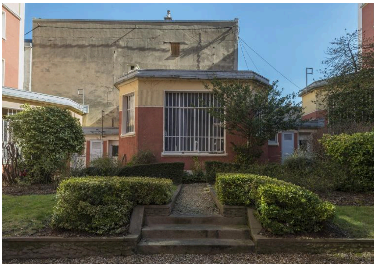
Vue des ateliers situés au rez-de-chaussée (10)
